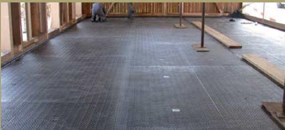
Beliebig grosse Flächen Urin- und Wasserdicht verlegt
